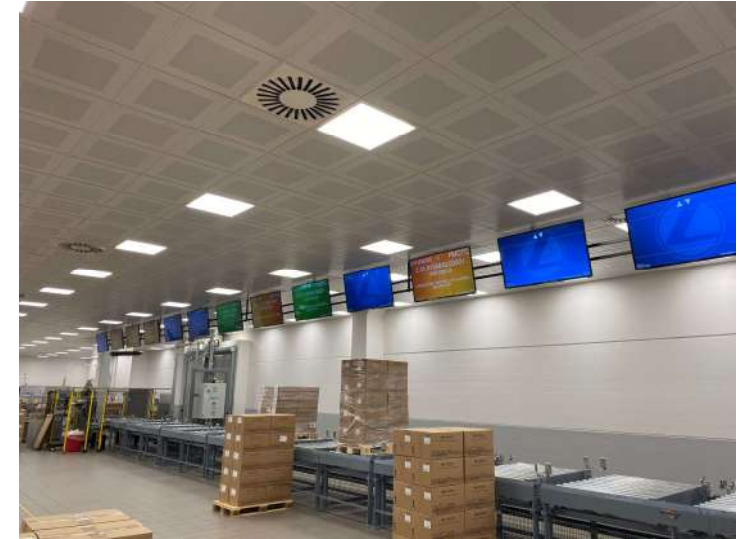
Postazioni di carico / scarico lato produzione + ingresso magazzino
